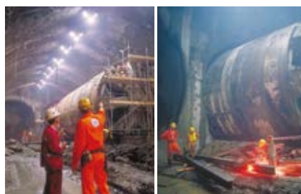
↑ Les tunneliers : capables de creuser 150 mètres par jour.
