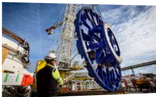
Puits Maréchal Leclerc à Massy. Descente de la roue de coupe du tunnelier © Gérard Rollando
