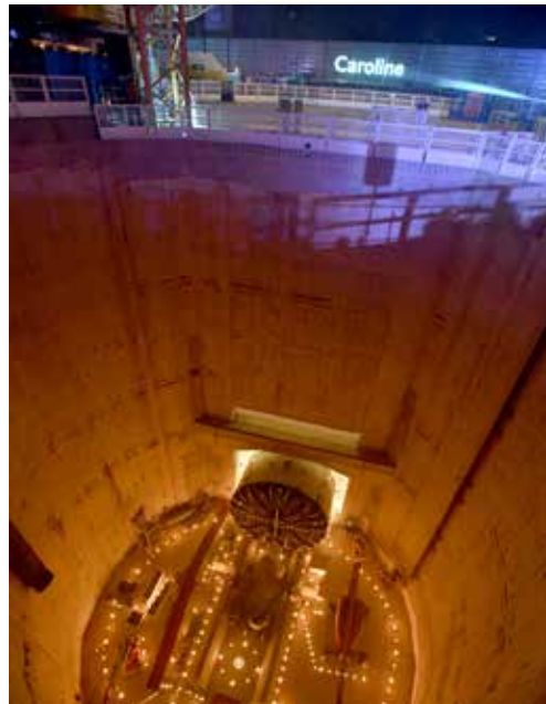
Descente et montage du tunnelier Caroline à Massy, sur la ligne 18 du futur métro Grand Paris Express. Mise en service prévue en 2026. ©SGP/Gérard Rollando
