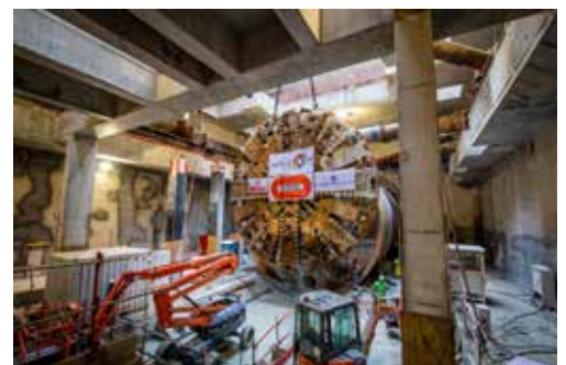
Descente et montage du tunnelier Caroline à Massy, sur la ligne 18 du futur métro Grand Paris Express. Mise en service prévue en 2026. ©SGP/Gérard Rollando
