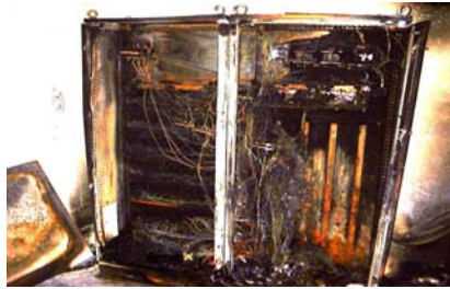
Armoire électrique détruite dans un incendie
